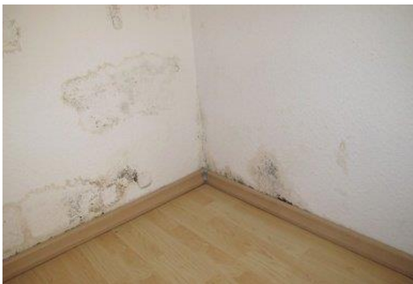
Figura 5 - Infiltração
