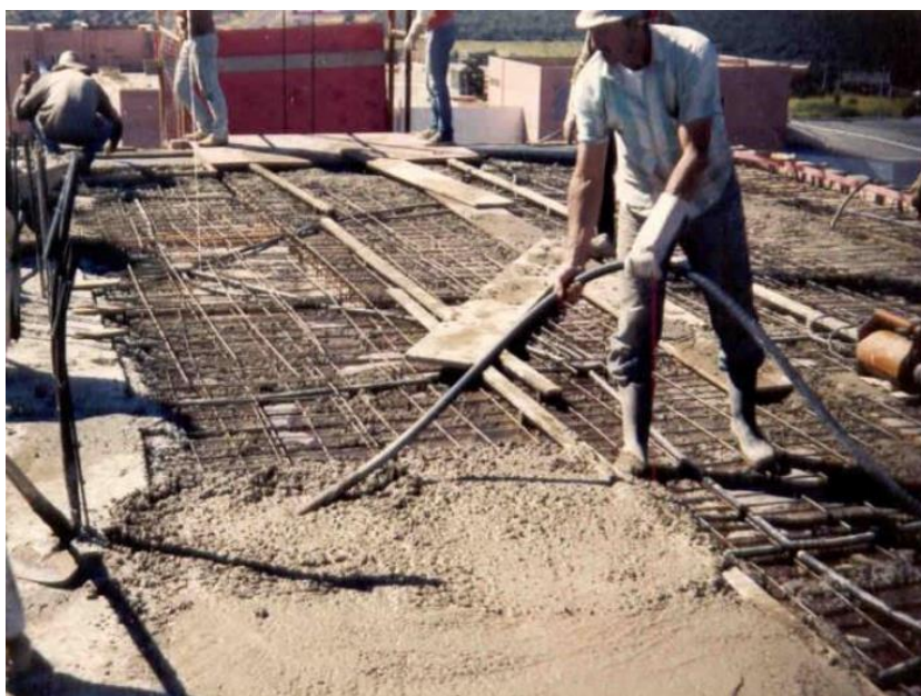
Figura 4 - Laje maciça sendo concretada
