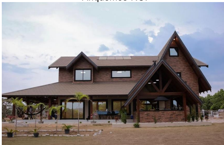
Figura 2 - Habitação em alvenaria estrutural utilizando tijolo ecológico em Ariquemes-RO.
