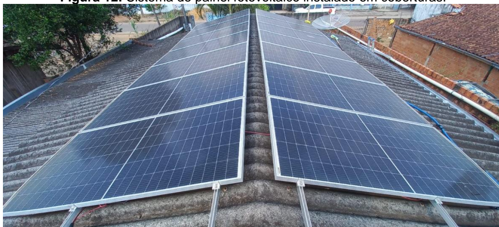
Figura 12: Sistema de painel fotovoltaico instalado em coberturas.
