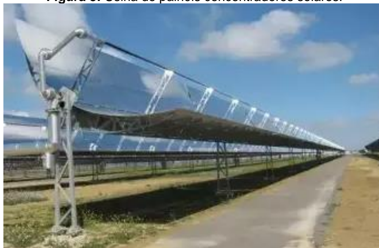
Figura 8: Usina de painéis concentradores solares.
