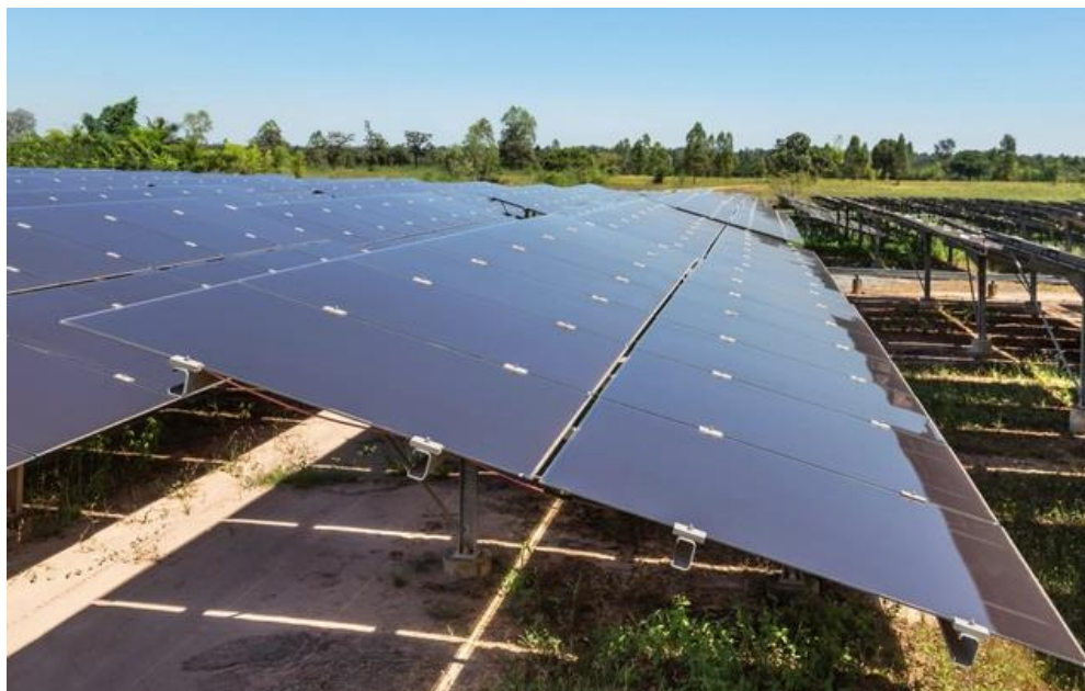
Figura 7 – Usina com painéis de filme fino
